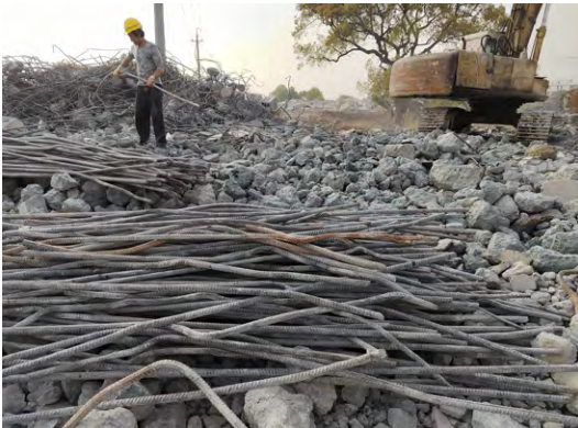
在杭州恒隆廣場拆解臨時混凝土支架 以回收鋼筋和混凝土碎片
