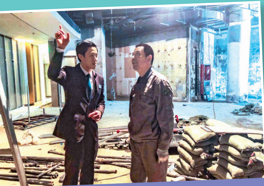
▲ 上海的恒隆广场的杨君（左）在工程现场与施工人员协商 Plaza 66's Yang Jun (left) coordinates with a worker at the construction site
