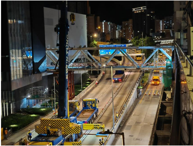
圖片五：施工中的淘大行人天橋
