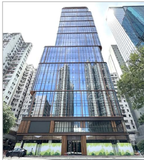
电气道228号 香港北角 (与恒隆地产共同发展)
