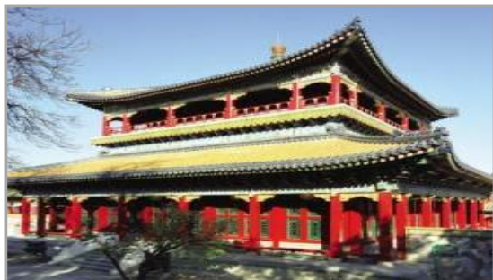
建福宫花园的复建工程于 2005年11月竣工
