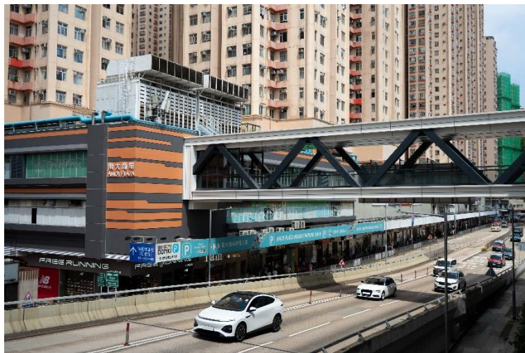
图片四：淘大行人天桥连接淘大商场、东九文化中心及九龙湾港铁站，为居民、上班人士及访客提供全天候、有盖及无障碍的便捷通道。
