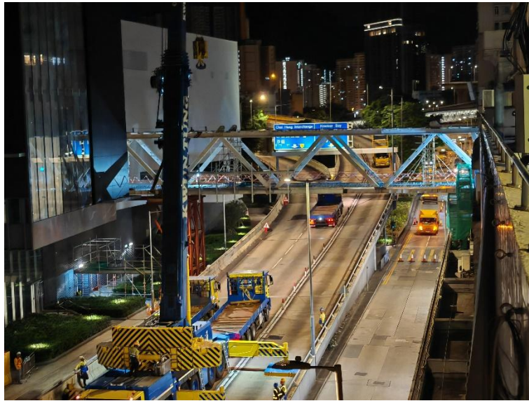
图片五：施工中的淘大行人天桥
