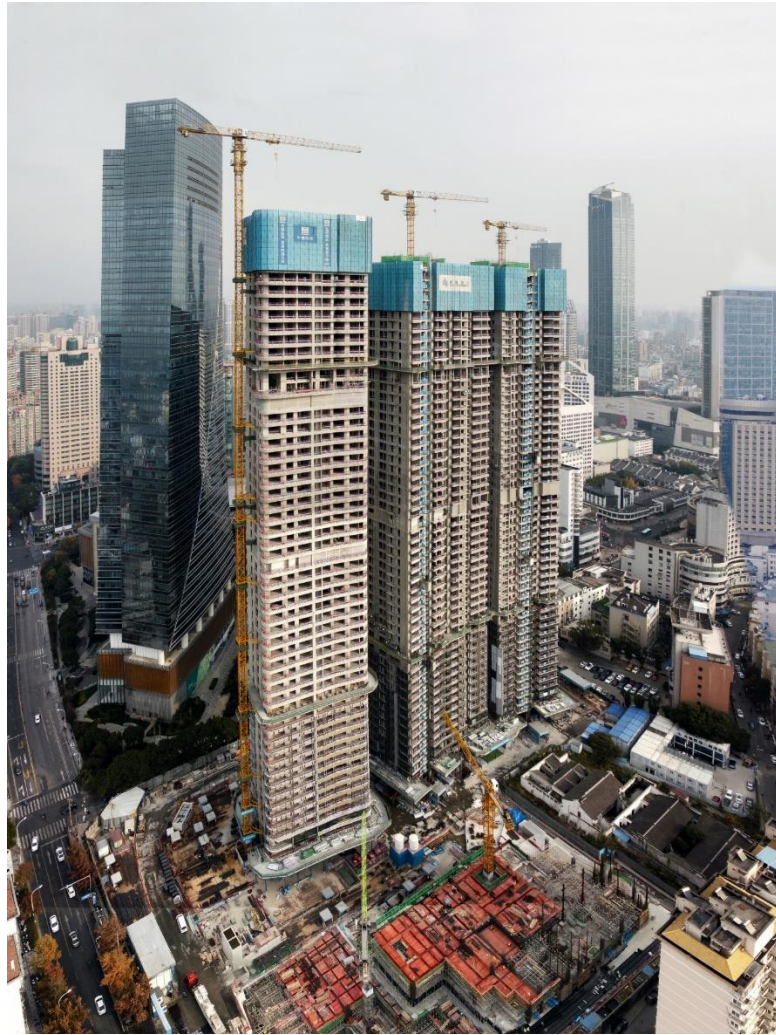
建設中的無錫「恒隆府」航拍圖
