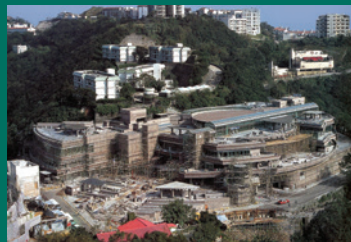
于1990年兴建 Construction started in 1990
