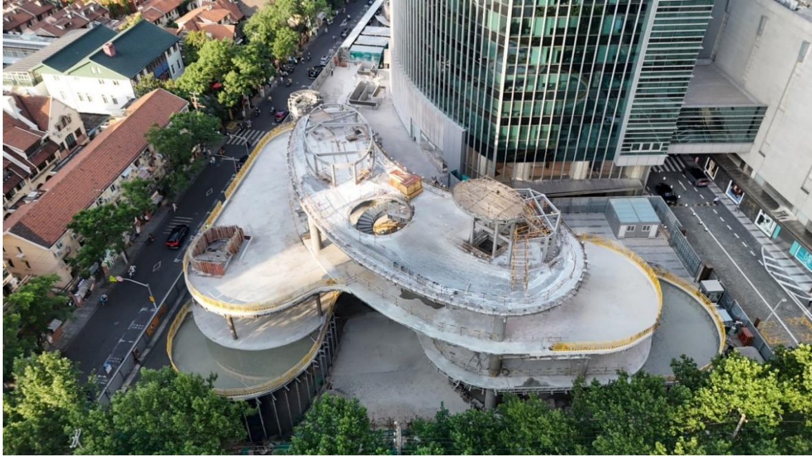
上海恒隆广场扩建项目如期封顶，将使可租赁零售面积增加 13%
