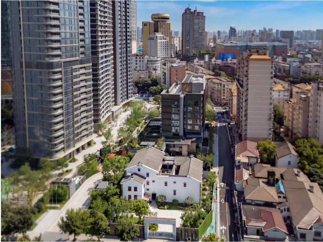
锡喆寓包含一栋现代风格的新楼及一座古建筑，新旧交融
