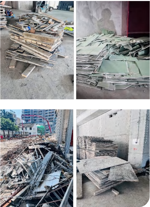
我们在杭州恒隆广场发展项目的工地的建筑废弃物（钢铁、石膏板和木材）现场分拣区域
