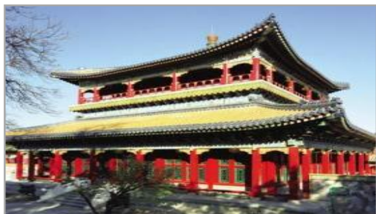
建福宫花园的复建工程于 2005年11月竣工
